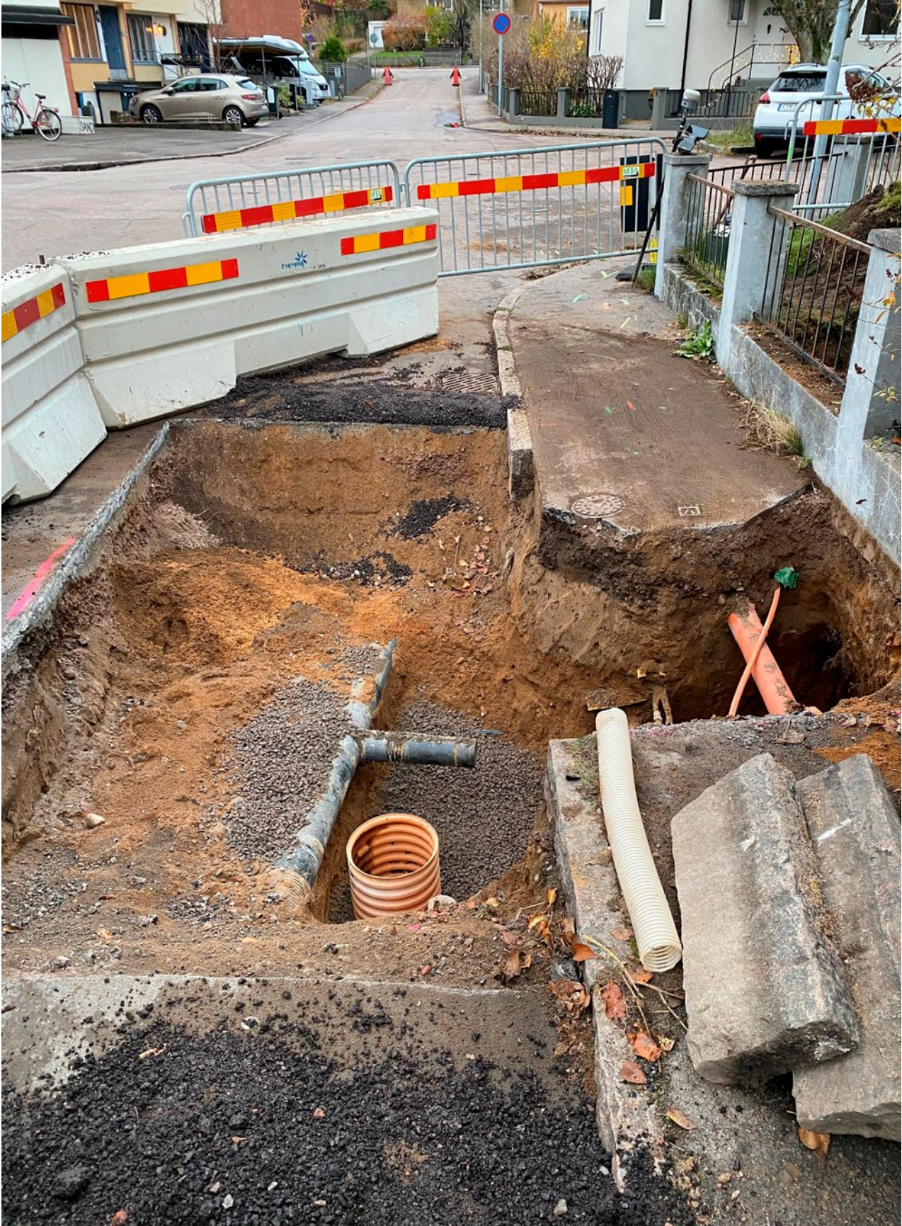
Figur 6. Översikt mot väst av schakt 2006. Foto: Lina Dahlqvist. (Fotonummer: 2024-101-3).
